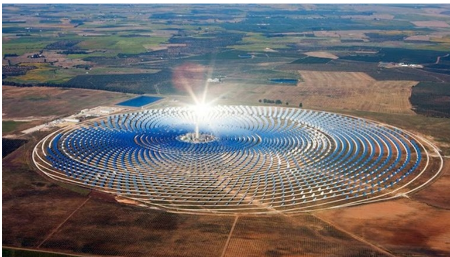
Figura 2 - Impianti a concentrazione solare
